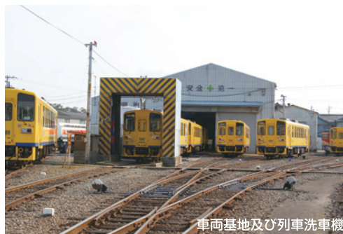
車両基地及び列車洗車機
